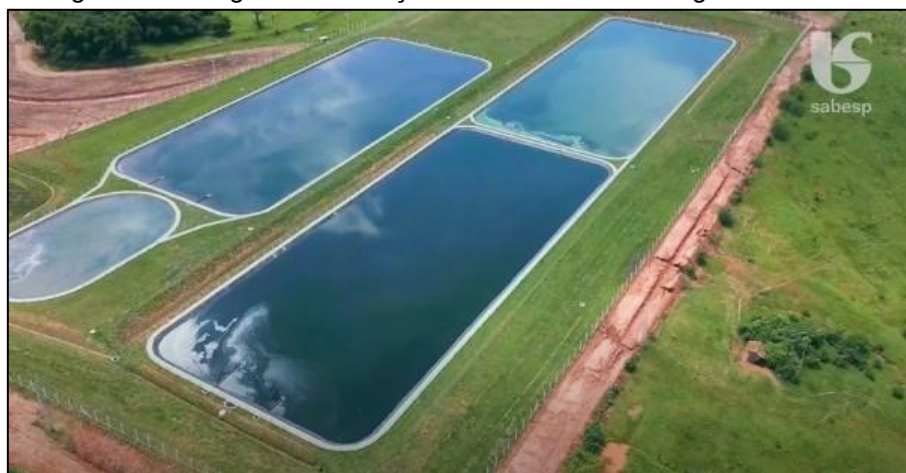
Figura 1 – Fotografia da Estação de Tratamento de Esgoto de Inúbia Paulista.
