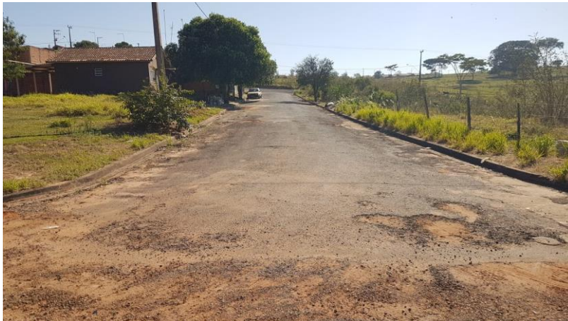
14 - Rua Paulo T. Watanabe Entre a Rua Vereador Miyashita Tiuiti e a Av. Kenji Muramatsu
