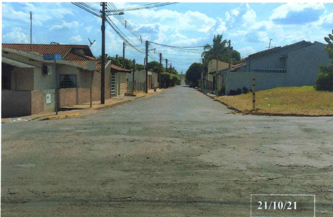
Local onde será substituído uma galeria de pneu, e implantado galeria tubos em concreto de 800 mm, e bocas de lobo que captará um maior volume de água. (Rua Benjamin Constant com Av. Leão Miguel Banwart).
