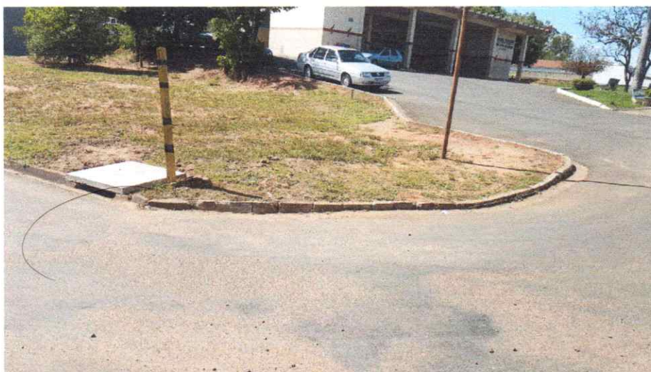
Foto da Área de Intervenção na Calçada – Item 6
