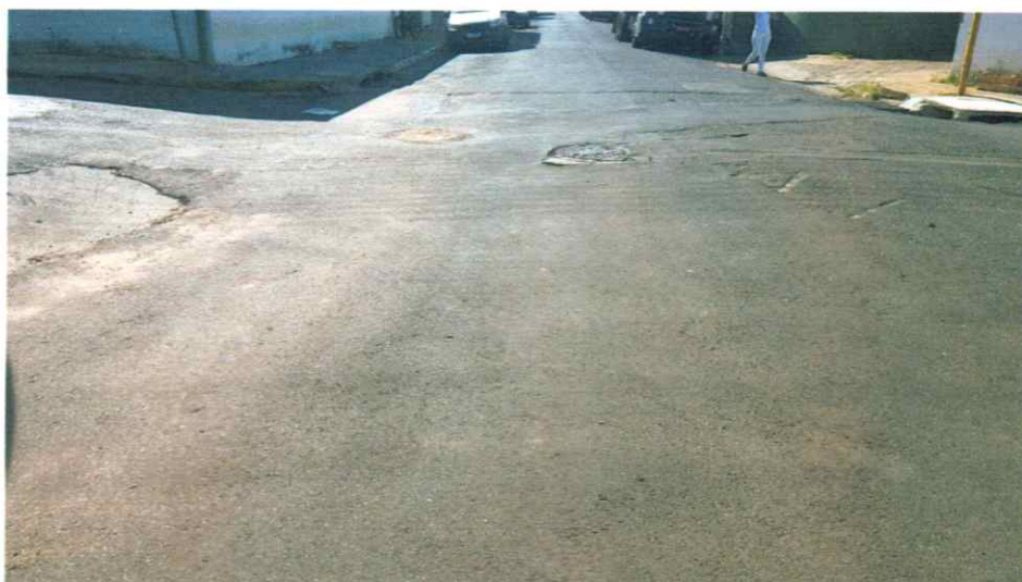
01 - RUA VER. LUIS CASSANDRE: trecho do cruzamento da Rua Miguel Pereira da Silva com a Rua Ver. Luis Cassandre.
