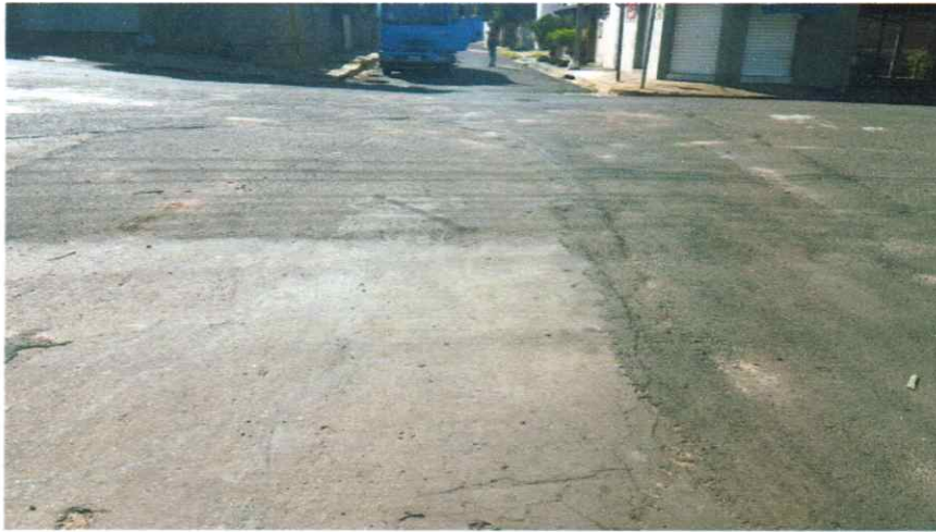
03 - RUA VER. LUIS CASSANDRE: trecho do cruzamento da Av. Marechal Deodoro da Fonseca com a Rua Vereador Luis Cassandre.
